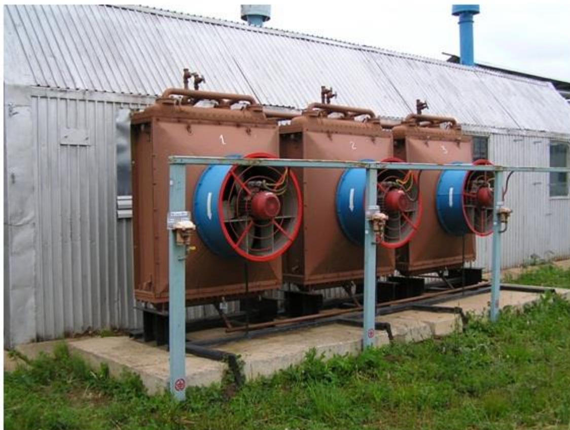
Рисунок 5.2 — Аппараты воздушного охлаждения масла
